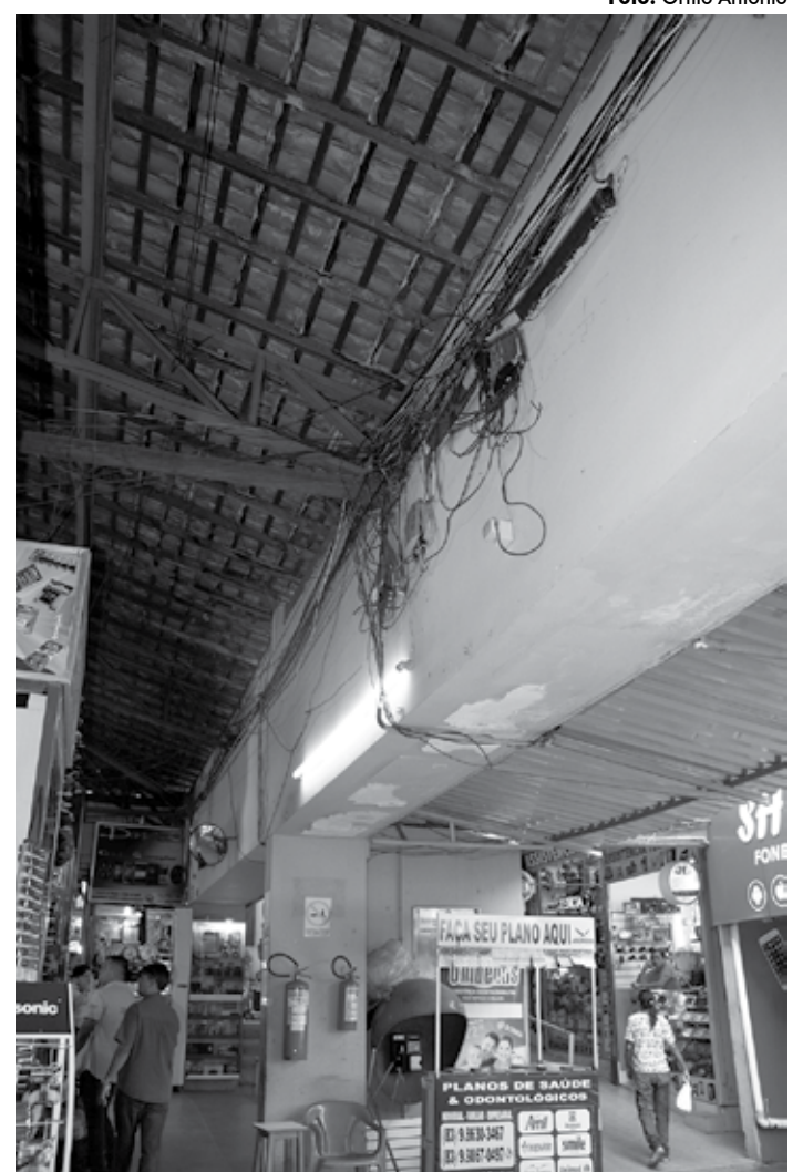
Fios entrelaçados mostram a falta de cuidados com a segurança no local
